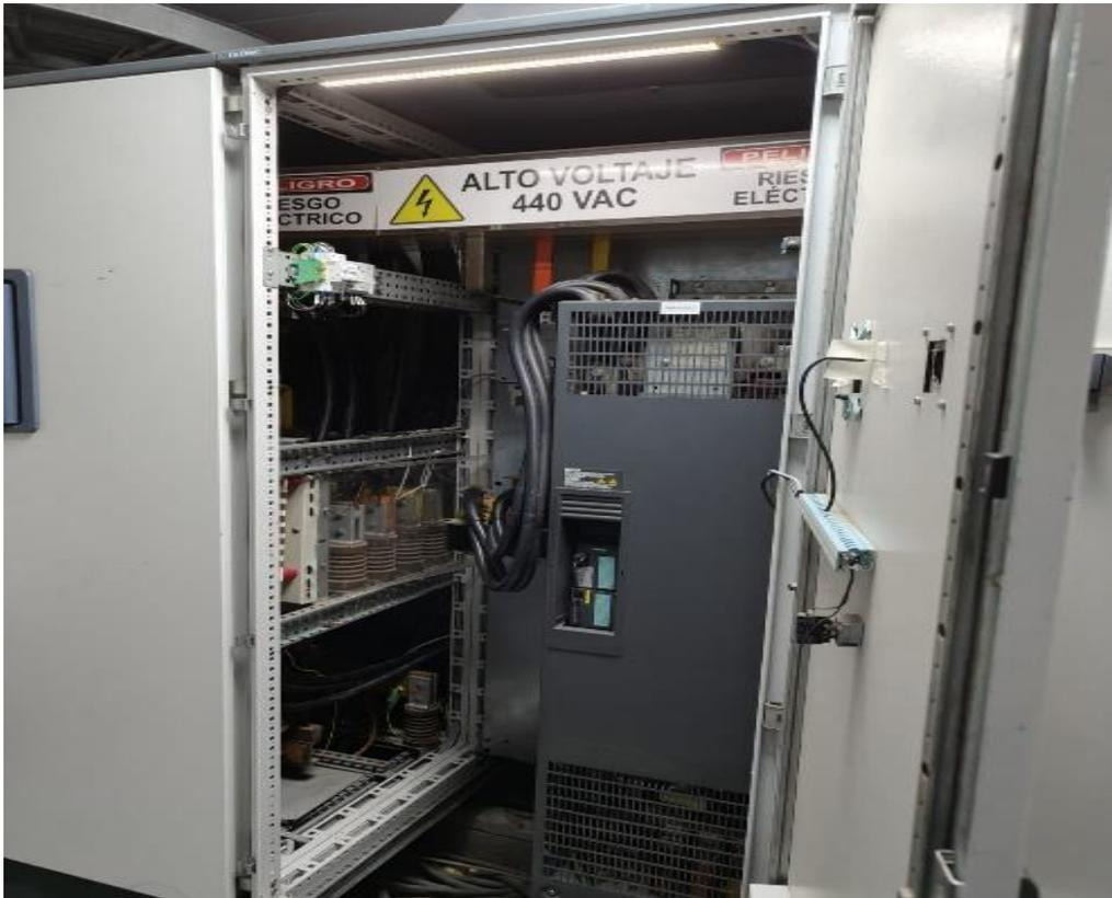
**CAMBIO DE TOTALIZADOR DEL VARIADOR DE FRECUENCIA:** Se requiere para el funcionamiento del variador de frecuencia encargado del funcionamiento del sistema de bombeo que distribuye el agua potable hacia el distrito.
